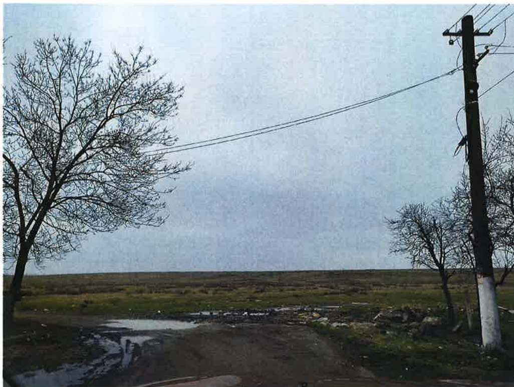
Foto 3. Strada 3 Aldești – intersecție cu drum lateral neamenajată, lipsă șanț și podeț descărcare ape pluviale
