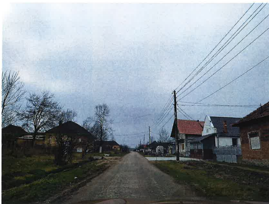
Foto 2. Strada 3 Aldești – acostament cu denivelări, lipsă trotuar partea stângă
