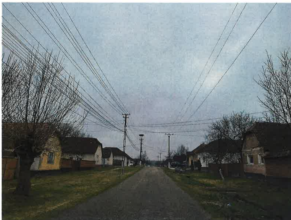
Foto 7. Strada 4 Bârsa – parte carosabilă cu suprafețe poroase, lipsă trotuare și accese adiacente amenajate corespunzător
